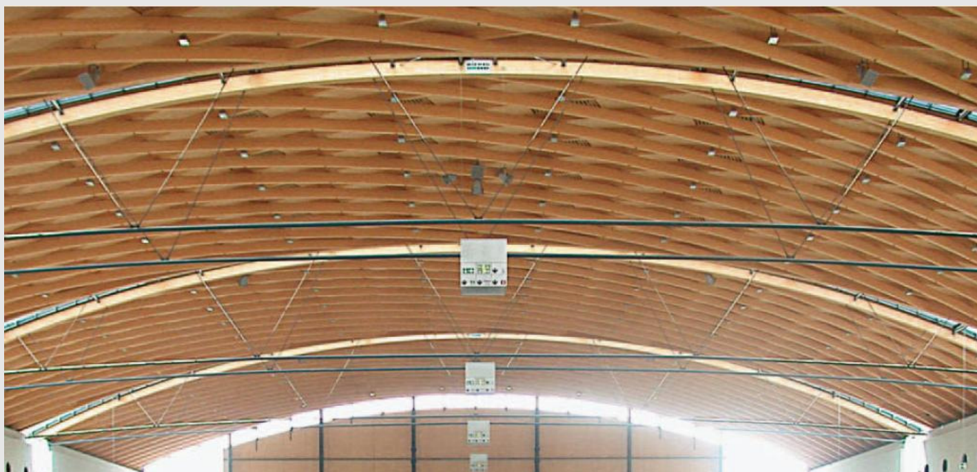
Construction de halls en bois lamellé collé
