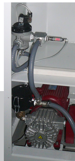
Sistema a depressione tramite pompa a vuoto Vacuum system by vacuum pump Système de vide par pompe à vide
